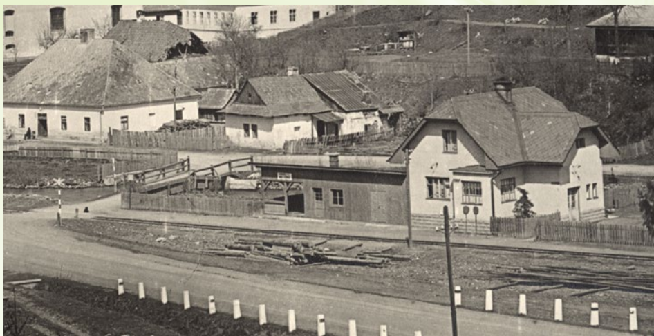
Obr. č. 4 Bývalá železničná stanica PLŽ-napravo strážnica, nľavo čakáreň
